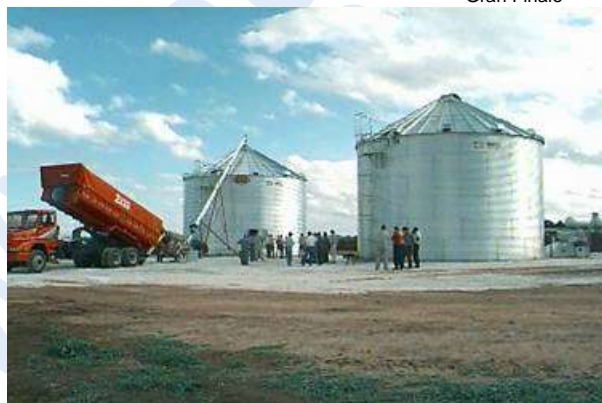
Figura 6 – Conjunto silo secador e silo armazenador.
