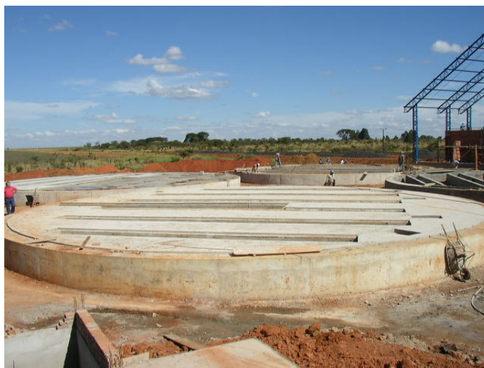
Figura 4 – Base para montagem de silo metálico (Gentileza da CASP)
