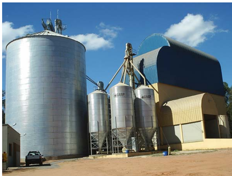
Figura 6 – Unidade armazenadora com três silos-plumão (Gentileza da CASP)
