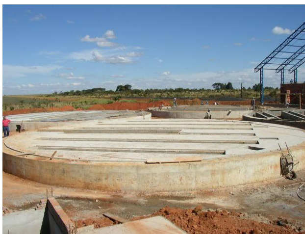
Figura 07 – Fundações para montagem de silo metálico (Divulgação – CASP).
