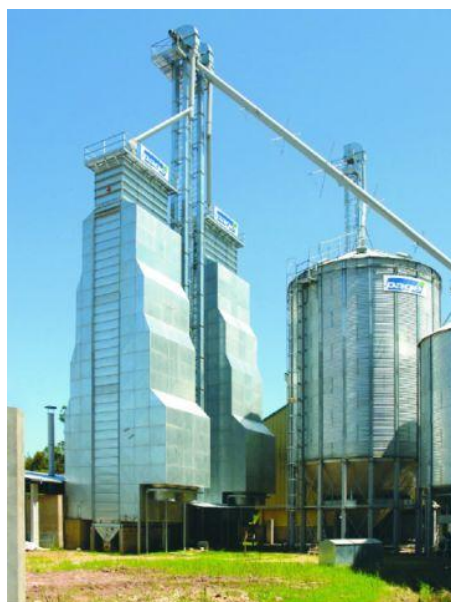
Figura 04 – À esquerda dois secadores de fluxos mistos e a direita um silo-pulmão com fundo inclinado (Divulgação – Page).
