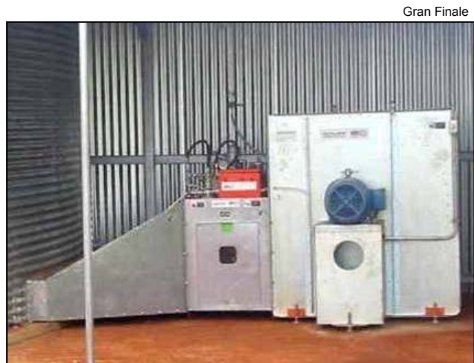
Figura 4 – Conjunto: ventilador e queimador de gás utilizados em secadores ao nível de fazenda (Gentileza da Gran Finale)
