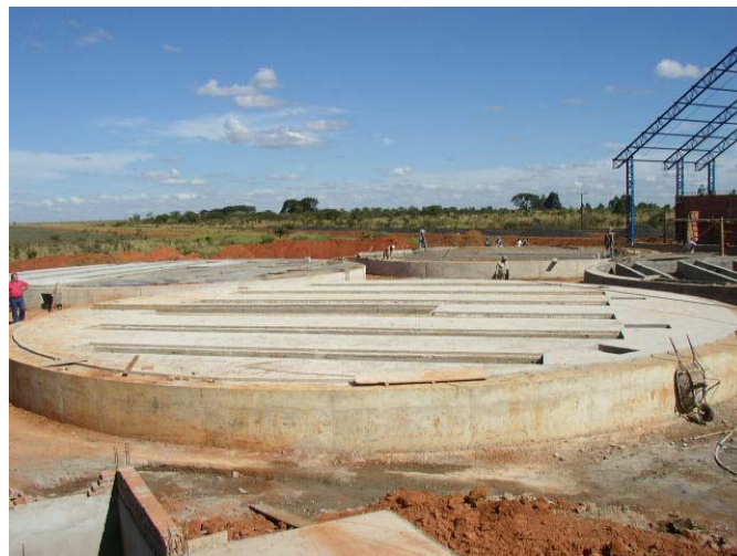
Figura 1 – Base para montagem de silo metálico (Gentileza da CASP)
