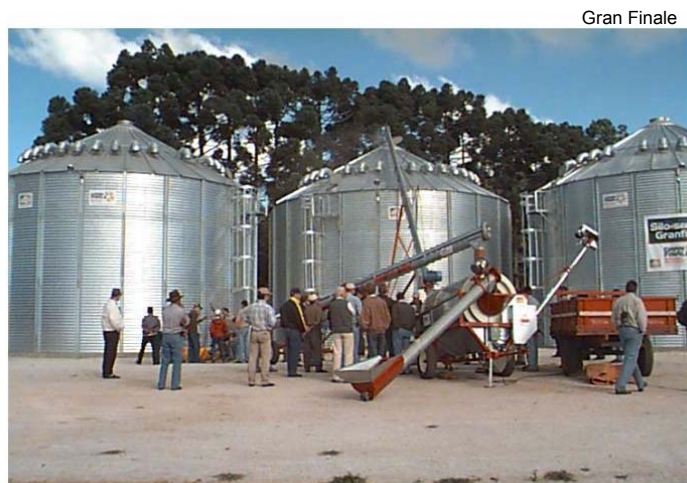
Figura 5 – Sistema de armazenagem ao nível de fazenda. Ao centro o silo secador, nas laterais os silos armazenadores (Gentileza da Gran Finale)
